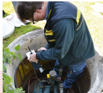
Der Servicetechniker verbindet die Messsonde mit der Rechen- und Kommunikationseinheit.
