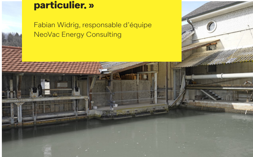
La centrale hydraulique du site produit environ 1'700 mégawattheures par an.
