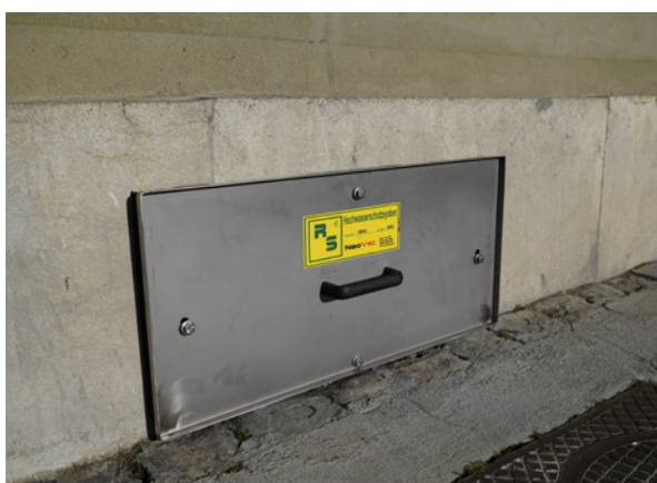
Au total, 16 cloisons pour fenêtre assurent désormais une protection contre les inondations.
